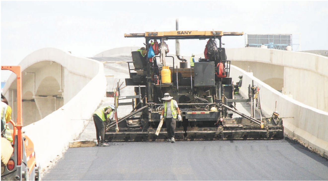
Mafundi ujenzi wakitandaza lami katika barabara ya juu Mataa ya Chang'ombe jijini Dar es Salaam jana. PICHA: JUMANNE JUMA
