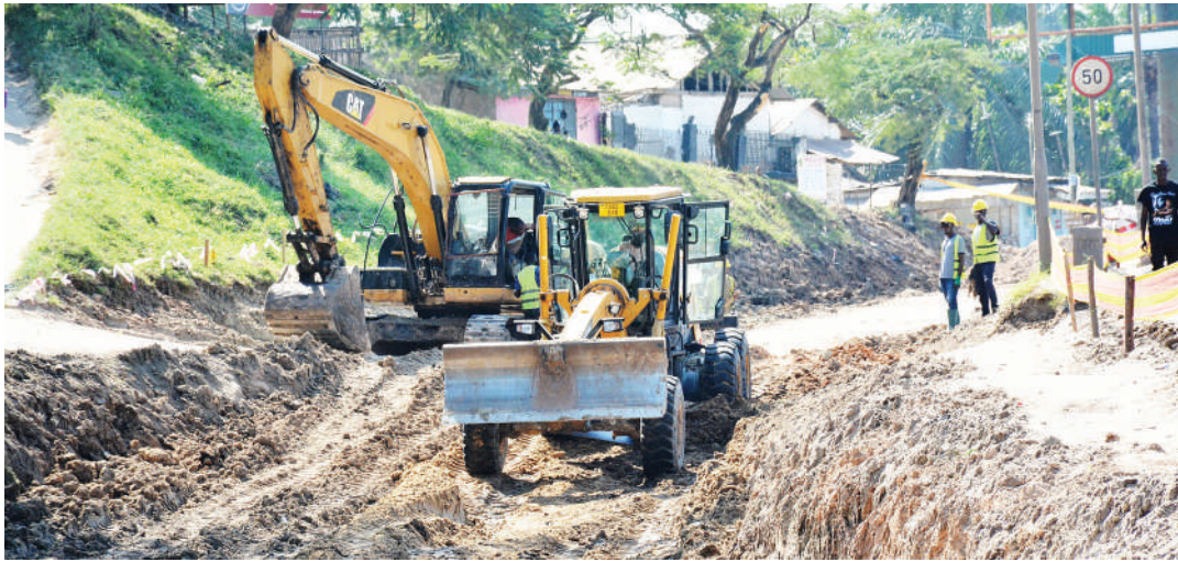
Kazi ya upanuzi wa barabara ya Morogoro kuanzia Kimara Mwisho hadi Ubungo, ikiendelea katika eneo la Korogwe, jijini Dar es Salaam jana. PICHA: MIRAJI MSALA
