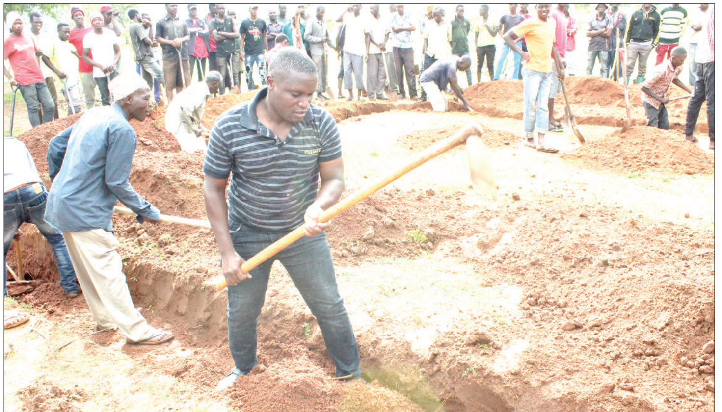
Mtendaji wa Kata ya Kolandoto, Manispaa ya Shinyanga, Mwakaluba Wilson, akiongoza wananchi wa kata hiyo, kuchimba msingi kwa ajili ya ujenzi wa vyumba viwili vya madarasa katika Shule ya Sekondari ya Kolandoto, ili kupunguza upungufu wa vyumba hivyo, uliopo shuleni hapo. Picha: MARCO MADUHU
