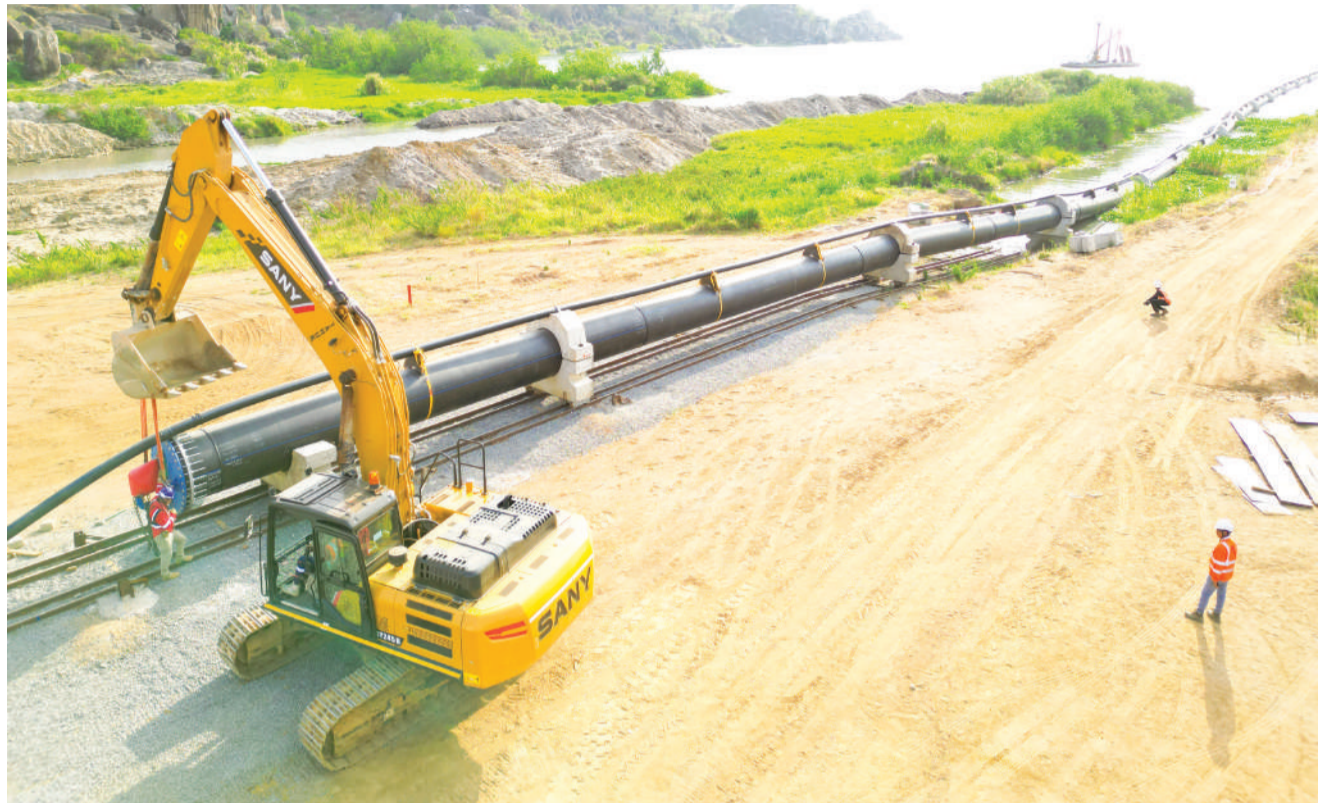
Kazi ya ujenzi wa Dakio la Butimba na Kituo cha Kutibu Maji ikiendela katika jiji la Mwanza ambapo ujenzi wake umefikia hatua ya zaidi ya asilimia 90, hivyo kuleta tumaini la kukamilika na kuanza kuhudumia wananchi. Picha mashine ikitumika katika kazi ya kuunganisha bomba kubwa litakalotumika kuvuta maji kutoka maji ziwani.
