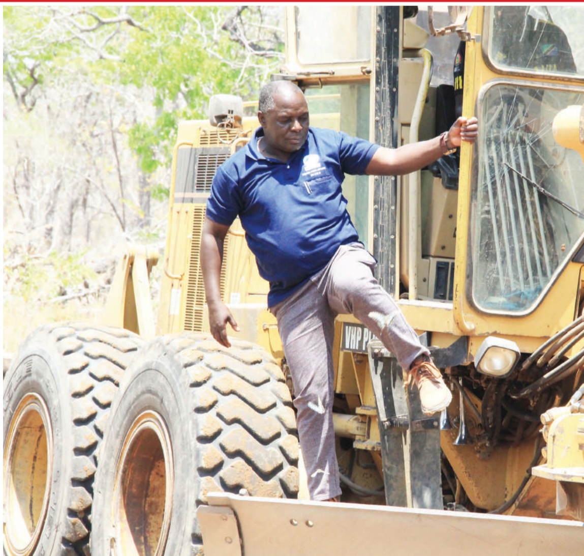
Meneja Wakala wa Barabara Tanzania (TANROADS), Mkoa wa Shinyanga, Mhandisi Mibara Ndirimbi, akiwa kwenye mtambo juzi, akikagua maendeleo ya ujenzi wa barabara mpya inayounganisha Halmashauri ya Ushetu wilayani Kahama na Wilaya ya Kaliua mkoani Tabora yenye urefu wa kilomita 25 kwa thamani ya Sh. bilioni 3.2. PICHA: MARCO MADUHU
