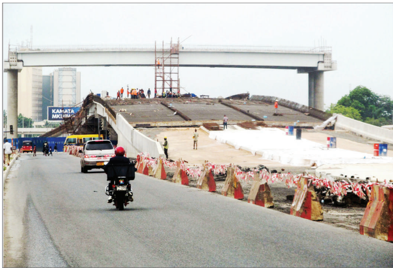
Mwonekano wa barabara za juu zinazojengwa Ubungo jijini Dar es Salaam, ambazo zikikamilika zinatarajia kupunguza msongamano wa magari jijini humo. Picha: SABATO KASIKA
