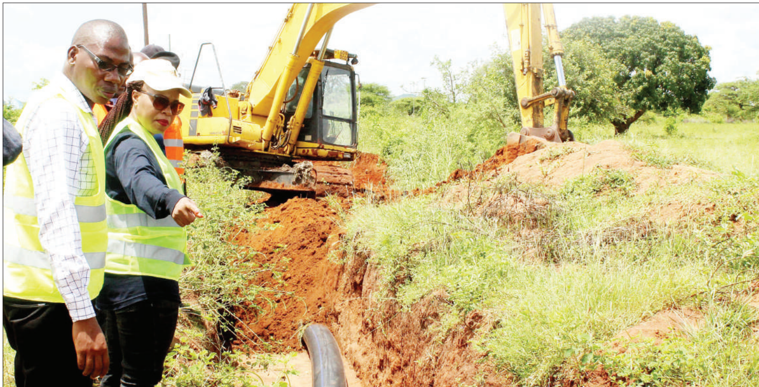
Mkuu wa Wilaya ya Shinyanga, Jasinta Mboneko (wa pili kushoto), akikagua ufukiaji wa mabomba kwenye mradi wa maji Ziwa Victoria, Kata ya Masengwa, Wilaya ya Shinyanga juzi. PICHA: MARCO MADUHU
