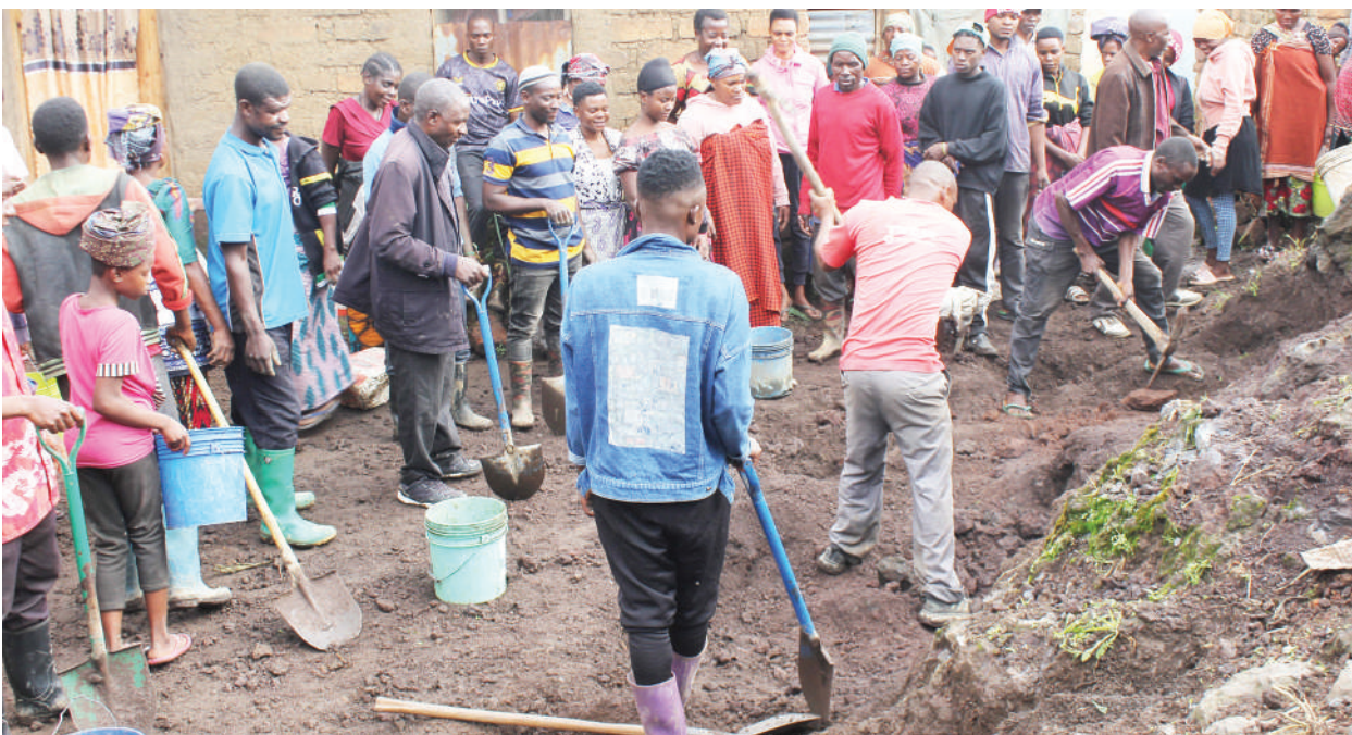
Wakazi wa Mitaa ya Majengo Mapya na Igamba, Kata ya Nsalaga, jijini Mbeya, wakishiriki kukarabati barabara juzi, baada ya kuharibika kutokana na mvua zinazoendelea kunyesha nchini. Picha: NEBART MSOKWA
