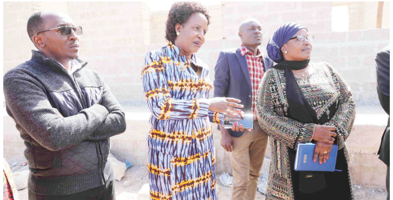
Mkuu wa Mkoa wa Dodoma, Rosemary Senyamule, akitoa maelezo kwa wasimamizi wa miradi ya ujenzi wa madarasa kuhakikisha unakamilika kwa wakati na ubora unaokubalika. Senyamule alikagua Shule ya Msingi Kisasi na Swaswa.
