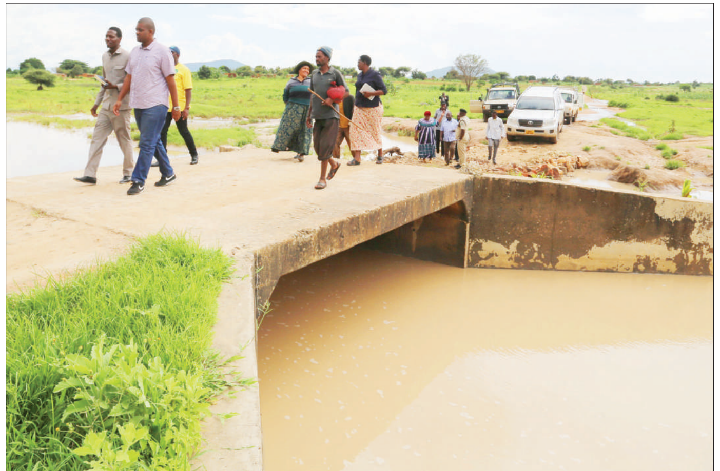
Mbunge wa Jimbo la Chamwino, Deogratius Ndejembu (kushoto), akikagua miundombinu ya daraja linalounganisha Kijiji cha Gwandi na Zajilwa Wilaya ya Chamwino mkoani Dodoma, mwisho wa wiki kwenye ziara yake ya kutembelea jimbo hilo. PICHA: IBRAHIM JOSEPH
