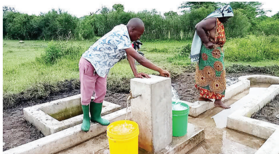
Wakazi wa Kijiji cha Nyanguge, wilayani Bariadi, mkoani Simiyu, wakipata huduma ya maji katika moja ya mabomba ya majisafi na salama kutoka kwenye visima virefu vinavyotumia umeme kutoka kwa Wakala wa Nishati ya Umeme Vijijini (REA) chini ya ufadhili wa Umoja wa Ulaya. PICHA: NDA-LIKE SONDA
