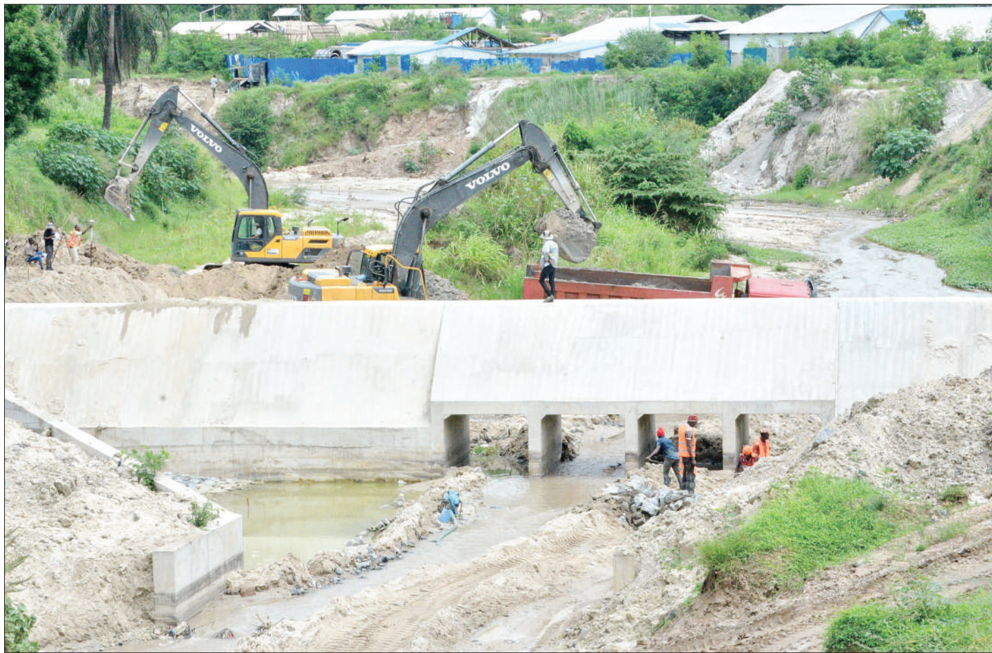
Mafundi wakiendelea na ujenzi wa kingo na upanuzi wa Mto Ng'ombe, eneo la Ubungo Maji, Manispaa ya Kinondoni, mkoani Dar es Salaam jana, ambapo awali ulikuwa ukielemewa na mafuriko nyakati za mvua na maji kuleta madhara kwenye makazi ya watu. PICHA: MIRAJI MSALA
