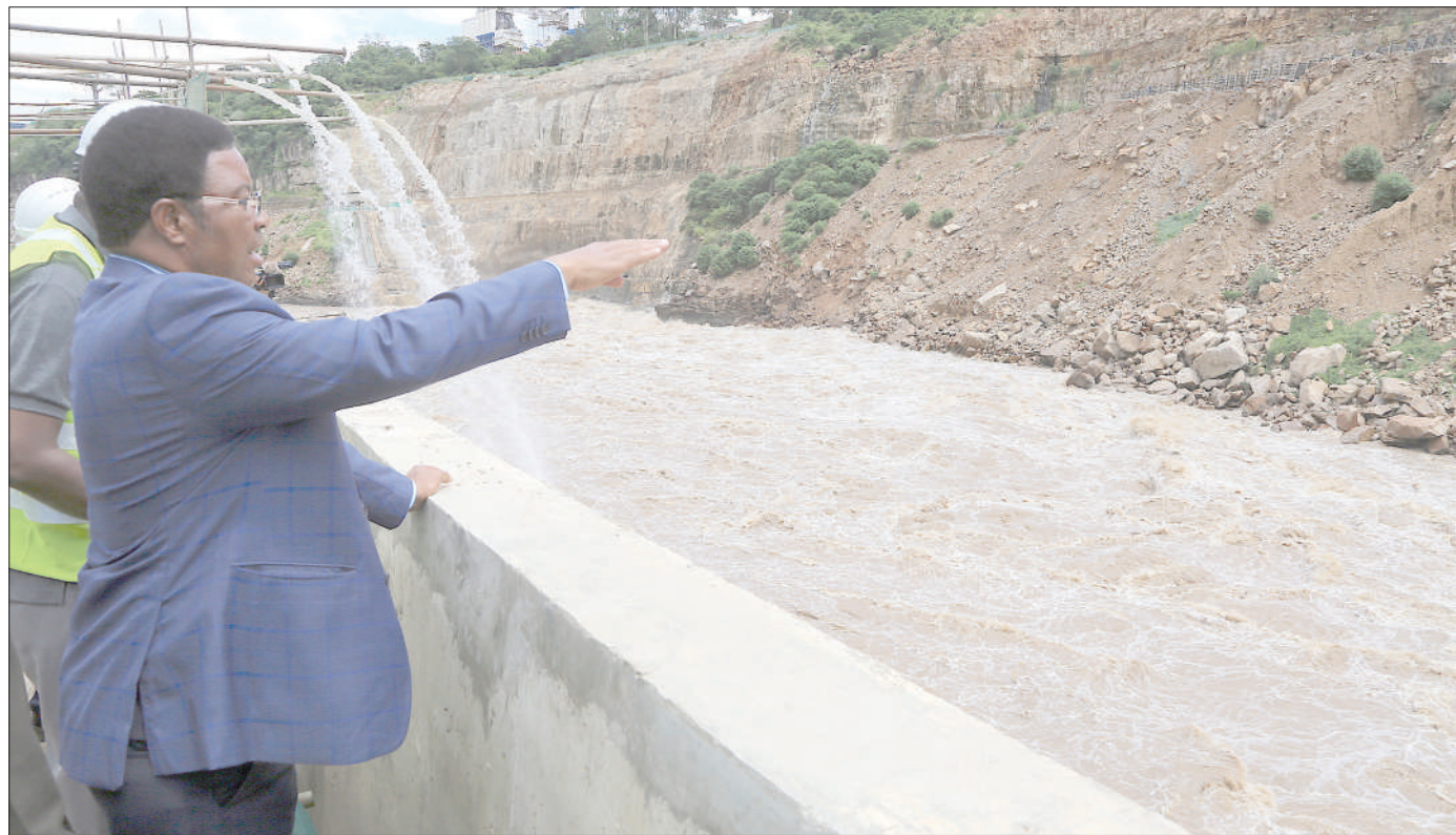
Waziri Mkuu Kassim Majaliwa, akikagua ujenzi wa mradi wa Bwawa la kuzalisha umeme la Nyerere, wilayani Rufiji, mkoani Pwani jana. Kushoto ni Naibu Waziri wa Nishati, Stephen Byabato. Picha: OWM
