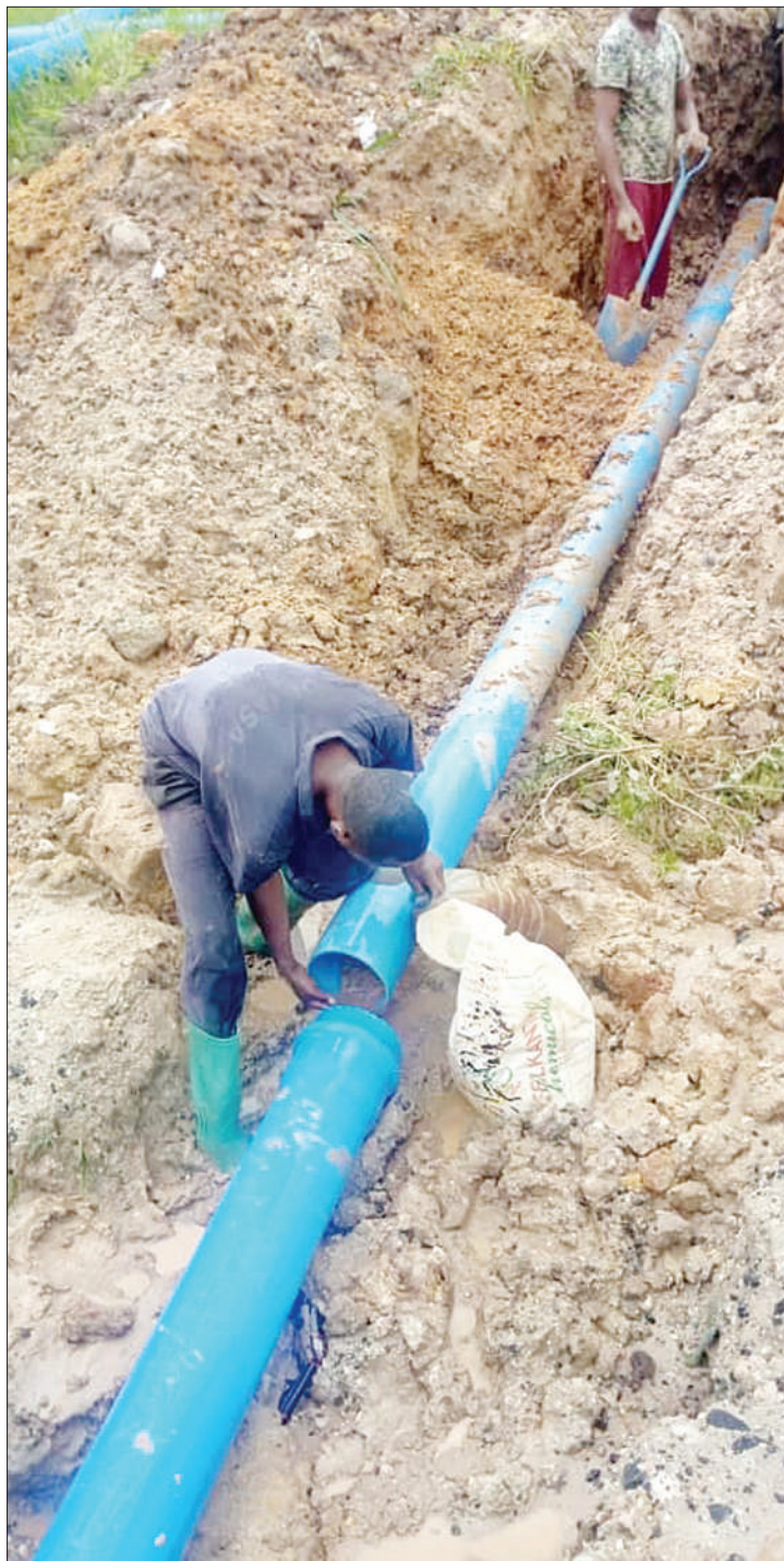
Mafundi kutoka Mamlaka ya Majisafi na Usafi wa Mazingira Dar es Salaam (DAWASA) wakilaza bomba eneo la Magari Saba kwa ajili ya kuongeza msukumo wa maji katika maeneo hayo. Zoezi hili litanufaisha mitaa ya Magari Saba, Takukuru Road, Madafu, Mnarani na Njiapanda ya Makonde wilayani Ubungo. PICHA: MPIOGAPICHA WETU
