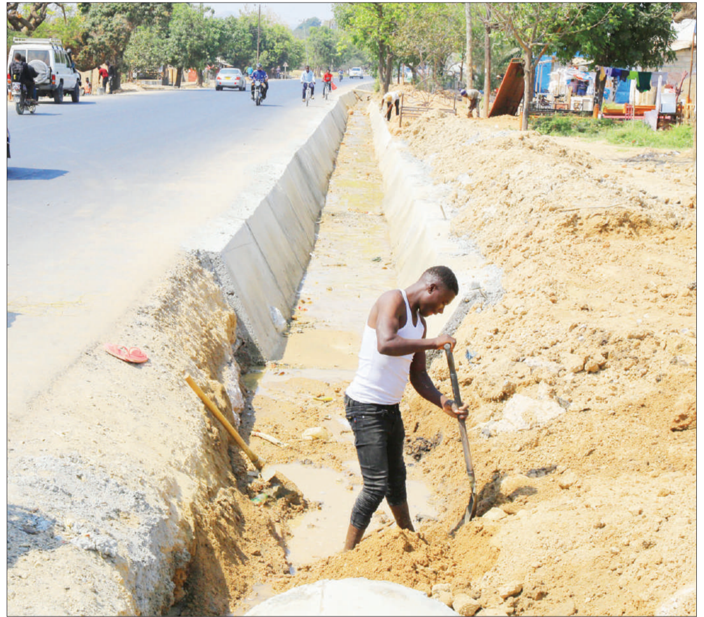
Mafundi wakiwa katika ujenzi wa mitaro ya maji katika Barabara ya Dodoma - Arusha, eneo la Mailimbili, jijini Dodoma jana. Eneo hilo, limekuwa na changamoto ya kujaa maji wakati wa msimu wa mvua na kusababisha barabara hiyo kuharibika. PICHA: IBRAHIM JOSEPH
