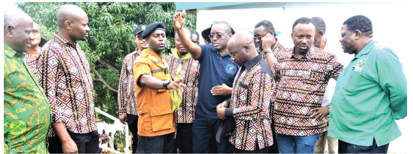
Kiongozi wa Mbio za Mwenge wa Uhuru Kitaifa 2023, Abdallah Shaibu Kaim (wa tatu kushoto), akipokea maelezo ya ujenzi wa tangi la kuhifadhi maji Mbweni kutoka kwa Kaimu Ofisa Mtendaji Mkuu wa Mamlaka ya Maji na Usafi wa Mazingira (DAWASA), Kiula Kingu wakati mbio za Mwenge katika Wilaya ya Kinondoni mapema wiki hii. PICHA: JOSEPH MWENDAPOLE
