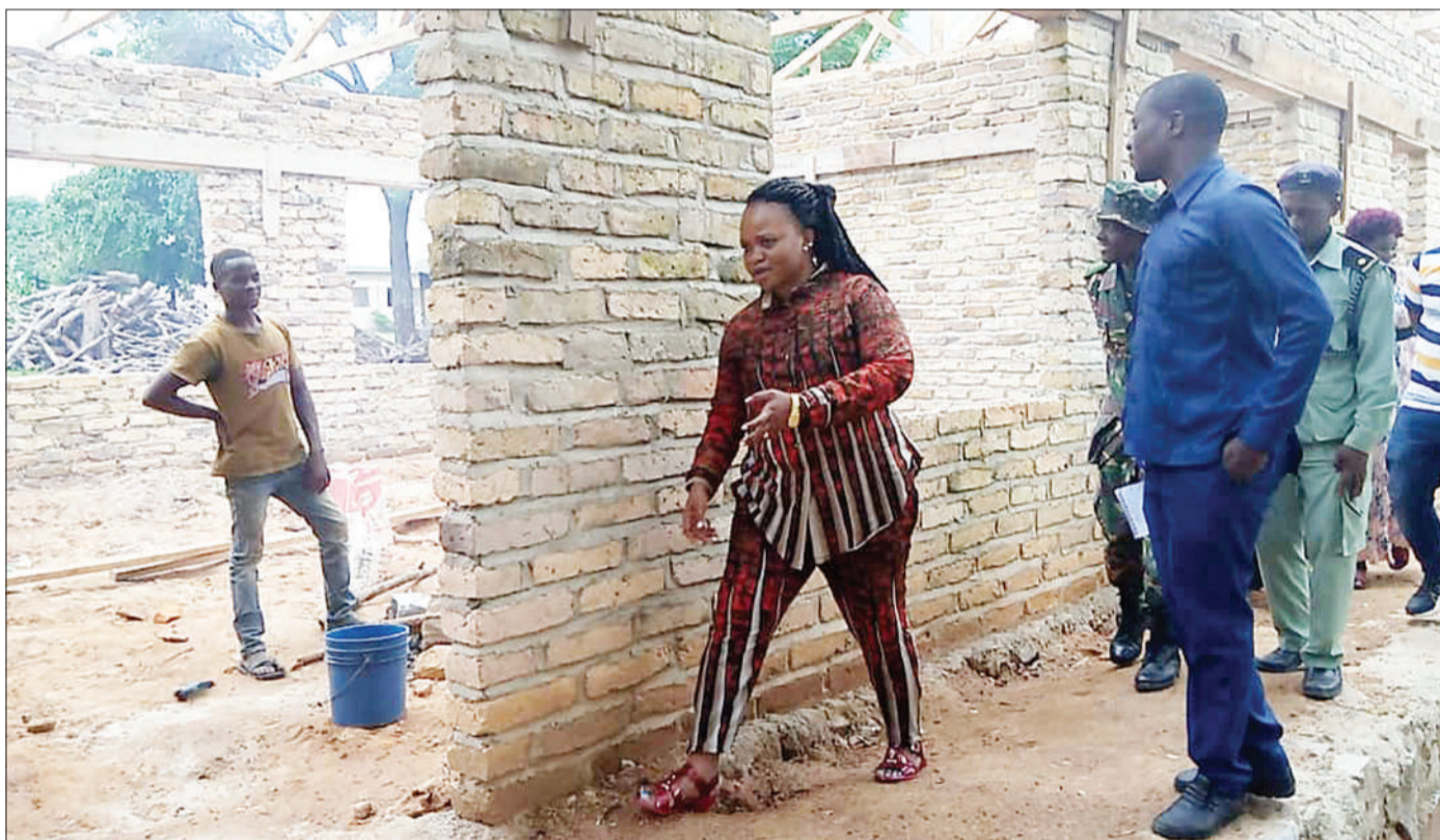
Mkuu wa Wilaya ya Chunya, mkoani Mbeya, Maryprisca Mahundi, akiwa ameongozana na wajumbe wa Kamati ya Ulinzi na Usalama ya Wilaya, kukagua vyumba vya madarasa vinavyojengwa wilayani humo, jana, kwa ajili ya wanafunzi wa kidato cha kwanza ambao wamekosa nafasi. PICHA: NEBART MSOKWA
