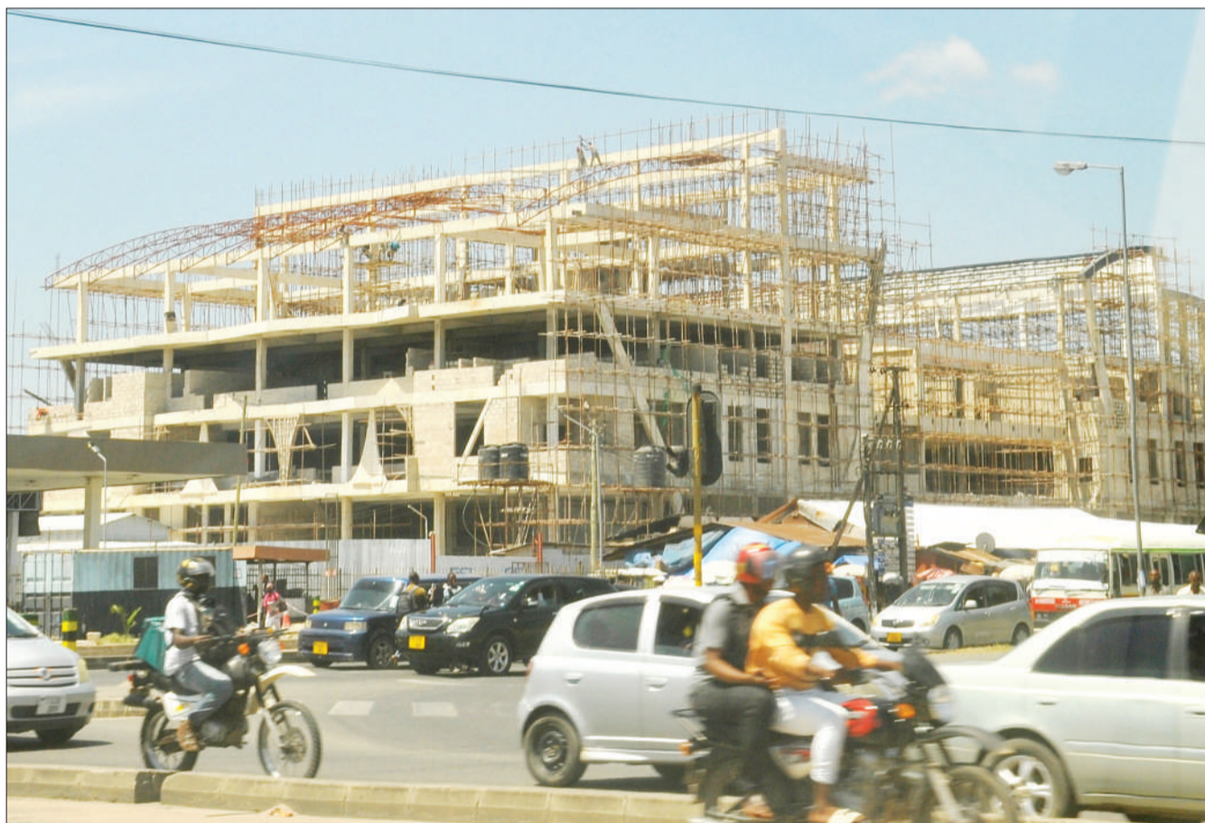
Mwonekano wa jengo la soko jipya la kisasa la Magomeni, litakalokuwa na ghorofa tatu, linaloendelea kujengwa na Manispaa ya Kinondoni, jijini Dar es Salaam jana. PICHA: JOHN BADI
