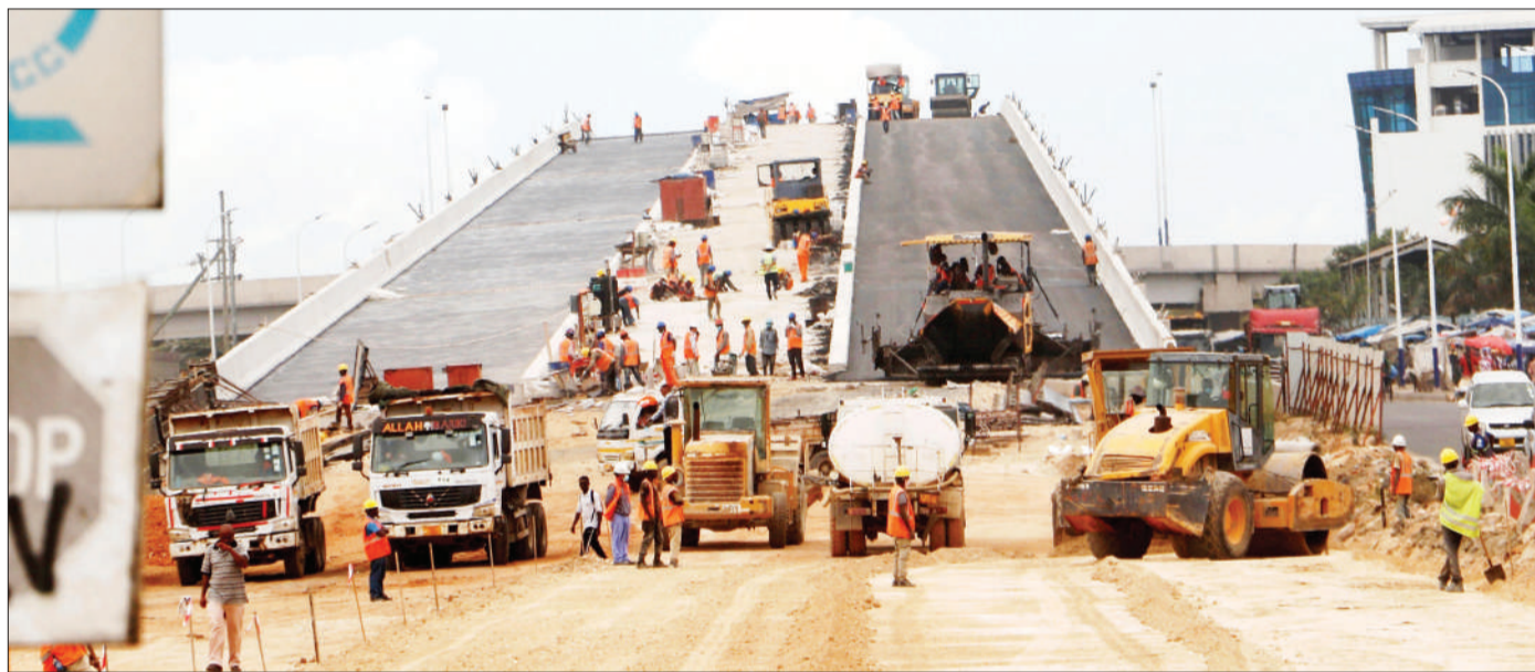
Mafundi wa kampuni ya CCECC, wakiendelea na ujenzi wa barabara za juu za mpishano katika makutano ya barabara za Morogoro, Sam Nujoma na Nelson Mandela, eneo la Ubungo, jijini Dar es Salaam jana. Picha: JUMANNE JUMA
