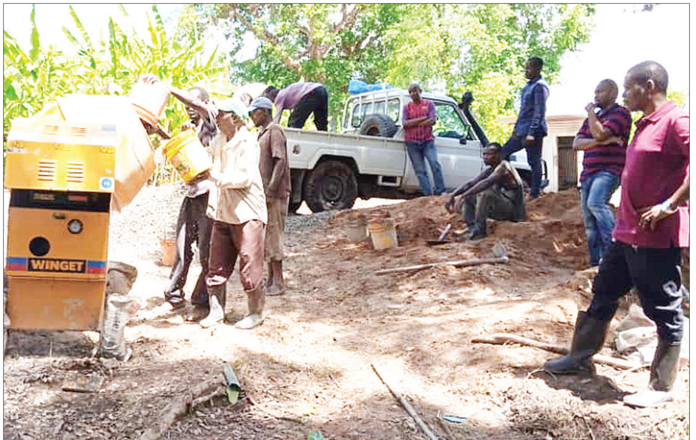
Mafundi mchundo wakikoroga zege kwa ajili ya kuanza ujenzi wa chumba cha mashine ya kusukuma maji katika chanzo cha maji cha Musa Toroka, katika Kijiji cha Rundugai, Wilaya ya Hai, mkoani Kilimanjaro juzi, huku Meneja Ufundi wa Mamlaka ya Majisafi na Usafi wa Mazingira Moshi (Muwsa), Mhandisi, Limbe Kija (kulia), akifuatilia kwa karibu. PICHA: GODFREY MUSHI
