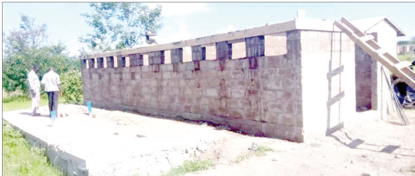
Jengo la vyoo vya Shule ya Sekondari mpya ya Kigera, iliyopo Kata ya Nyakatende, Jimbo la Musoma Vijijini mkoani Mara, likiwa katika hatua ya kupauliwa. Shule hiyo inatarajiwa kupokea wanafunzi wa kidato cha kwanza mwaka ujao. PICHA: MPIGA PICHA WETU
