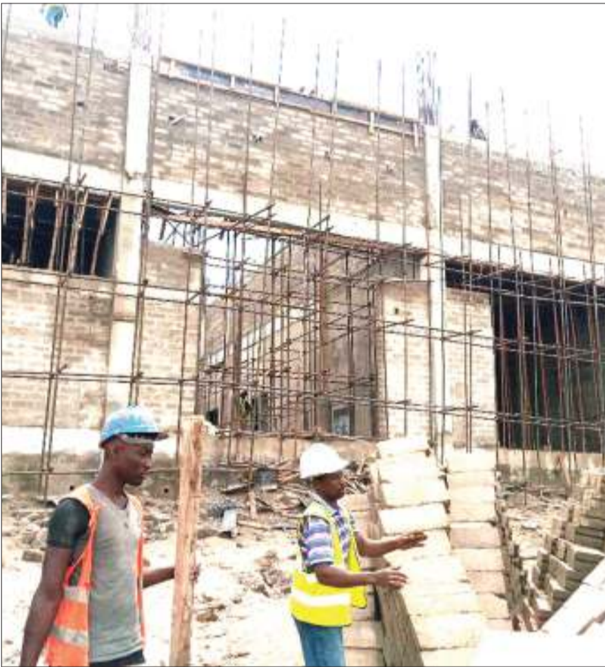
Mafundi wakiendelea na ujenzi wa machinjio ya kisasa ya Vingunguti, jijini Dar es Salaam jana. Kwa mujibu wa mkandarasi anayesimamia ujenzi huo, Wakala wa Nyumba (TBA), hadi kufikia mwezi Desemba mwaka huu, watakuwa wamezeka paa la machinjio hayo. PICHA: JOSEPH MWENDAPOLE
