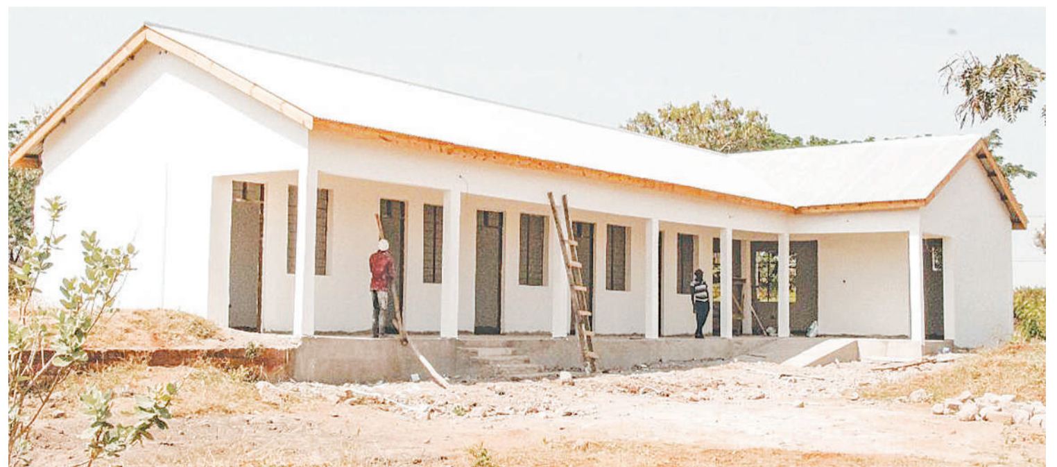
Zahanati ya Kijiji cha Mwamagunguli Manispaa ya Shinyanga, ujenzi unaendelea.
