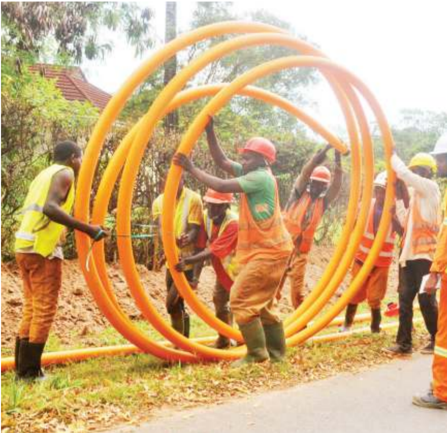
Wafanyakazi wa kampuni ya Gasco, wakitandaza mabomba kwaajili ya usambazaji wa gesi ya matumizi ya nyumbani katika nyumba 85 zikiwamo za mawaziri, katikane eneo la Mikocheni, jijini Dar es Salaam mapema wiki hii. PICHA: JOHN BADI
