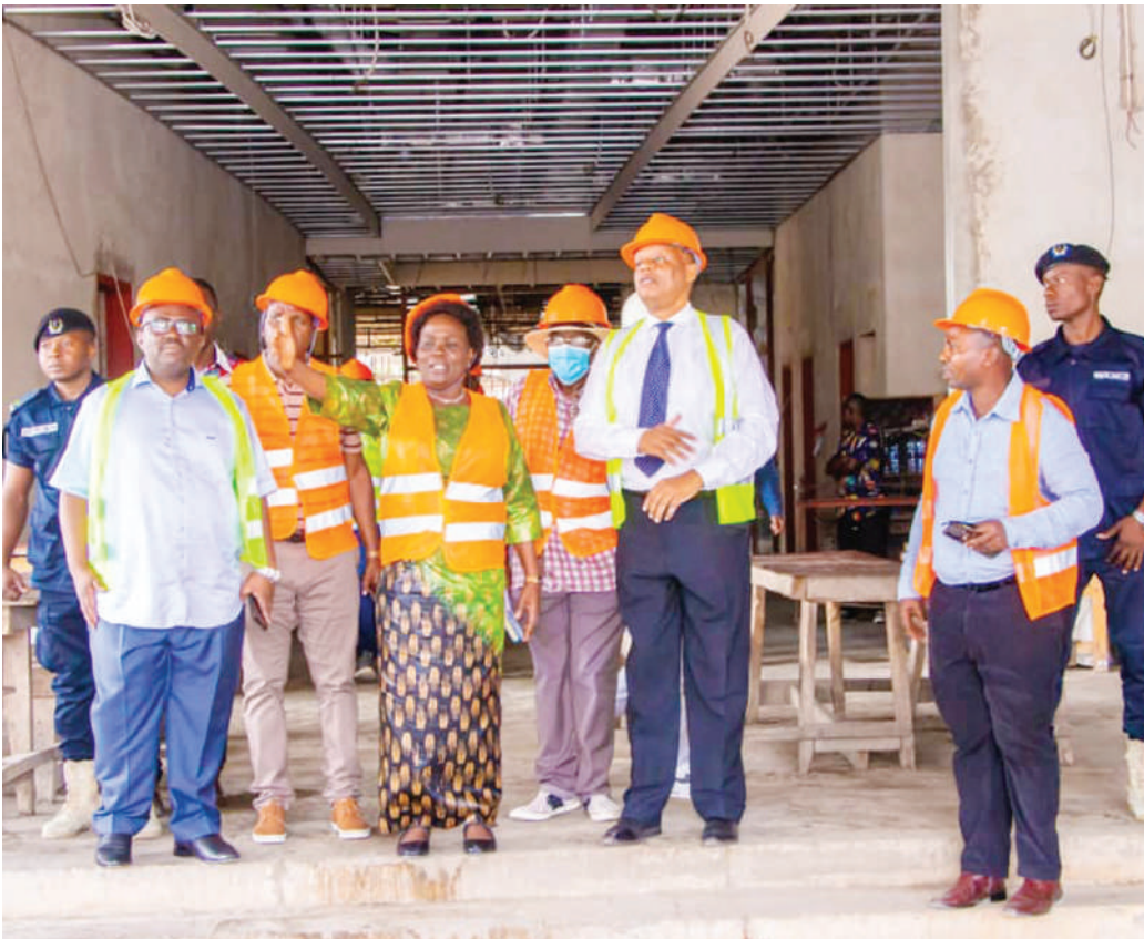
Waziri wa Nchi, Ofisi ya Waziri Mkuu, Kazi, Vijana, Ajira na Wenye Ulemavu, Prof. Joyce Ndali-chako (katikati), akikagua maendeleo ya ujenzi wa mradi wa uwekezaji wa jengo la Mzizima Tower jijini Dar es Salaam, linalomilikiwa na NSSF. HABARI UK 5. PICHA: MPIGAPICHA WETU
