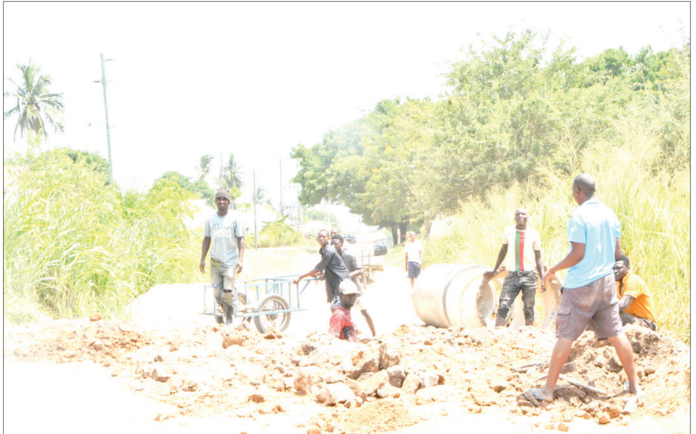
Wananchi wakijitolea kuweka kalavati za kupitisha maji katika barabara inayounganisha vijiji vya Madafu na Madabara, Mkoa wa Pwani, mapema wiki hii, kutokana na eneo hilo kuwa korofi hasa nyakati za mvua. PICHA: MIRAJI MSALA
