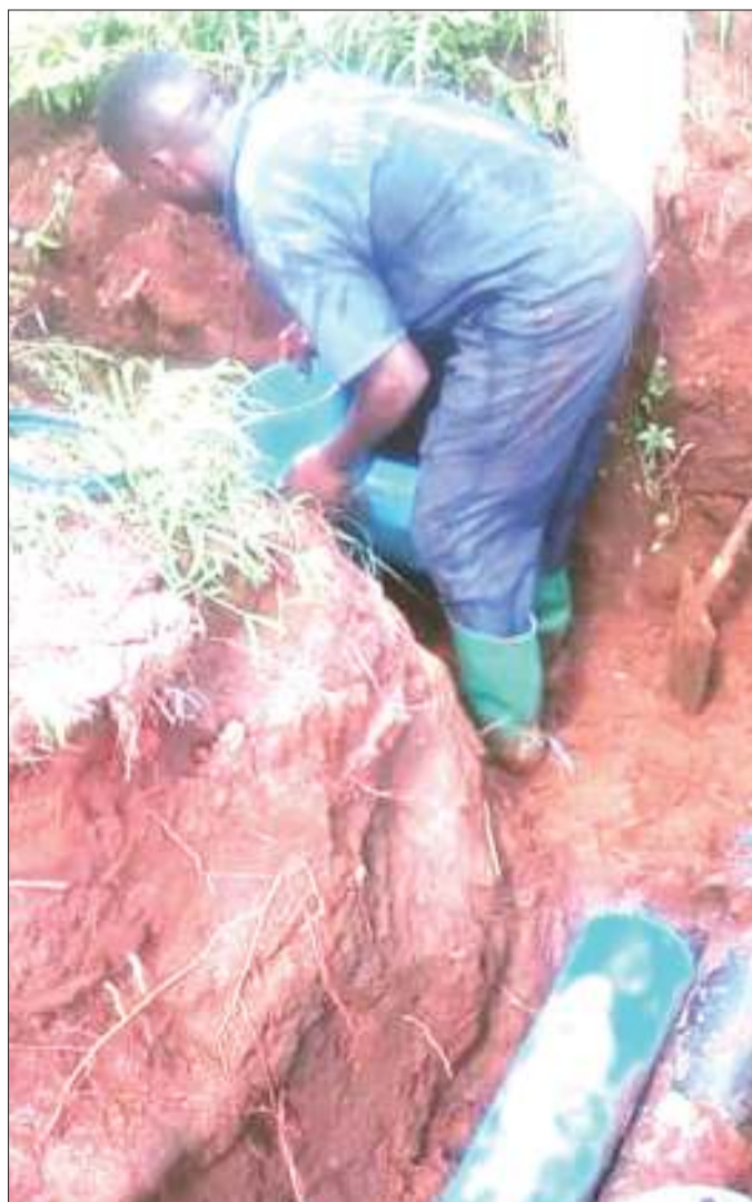
Fundi wa Mamlaka ya Majisafi na Usafi wa Mazingira (DAWASA), Ubungo, Oscar Godwin, akirekebisha bomba la inchi nane katika eneo la Luguruni, Manispaa ya Ubungo, jijini Dar es Salaam juzi, kwa lengo la kuongeza kasi ya upatikanaji na uboreshaji wa huda ya maji. Picha: MPIGA Picha Wetu
