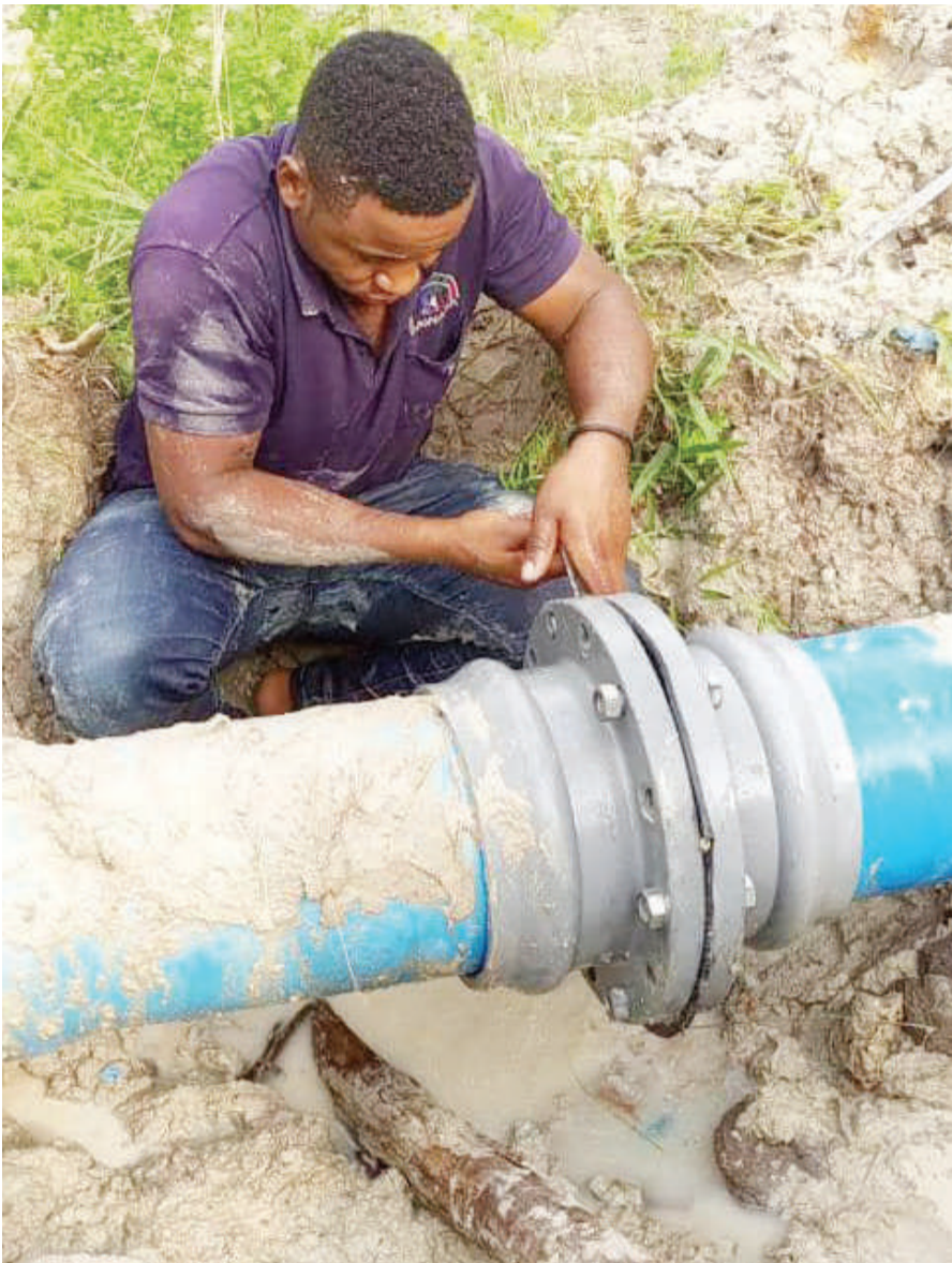
Fundi wa Mamlaka ya Majisafi na Usafi wa Mazingira Dar es Salaam (DAWA-SA), Kilian Luwena, akidhibiti upotevu wa maji katika bomba la inchi 10 jirani na Kanisa la Efatha, Kata ya Saranga, jana. PICHA: JOSEPH MWENDAPOLE
