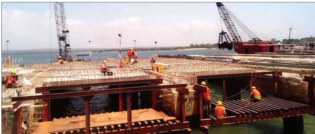
Kazi ya ujenzi wa gati la Bandari ya Tanga, ikiendelea. PICHA: BONIFACE GIDEON.
