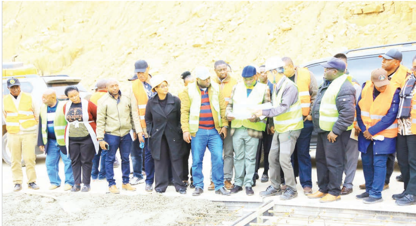
Mhandisi Mshauri wa Kampuni ya Yooshin Engineering Corporation, Moon, akiwaonyesha wajumbe wa Kamati ya Kudumu ya Bunge ya Miundombinu mpango kazi unaoendelea wa ujenzi wa barabara ya Lusitu - Mawengi (km 50), kwa kiwango cha zege, mkoani Njombe. PICHA: MPIGAPICHA WETU
