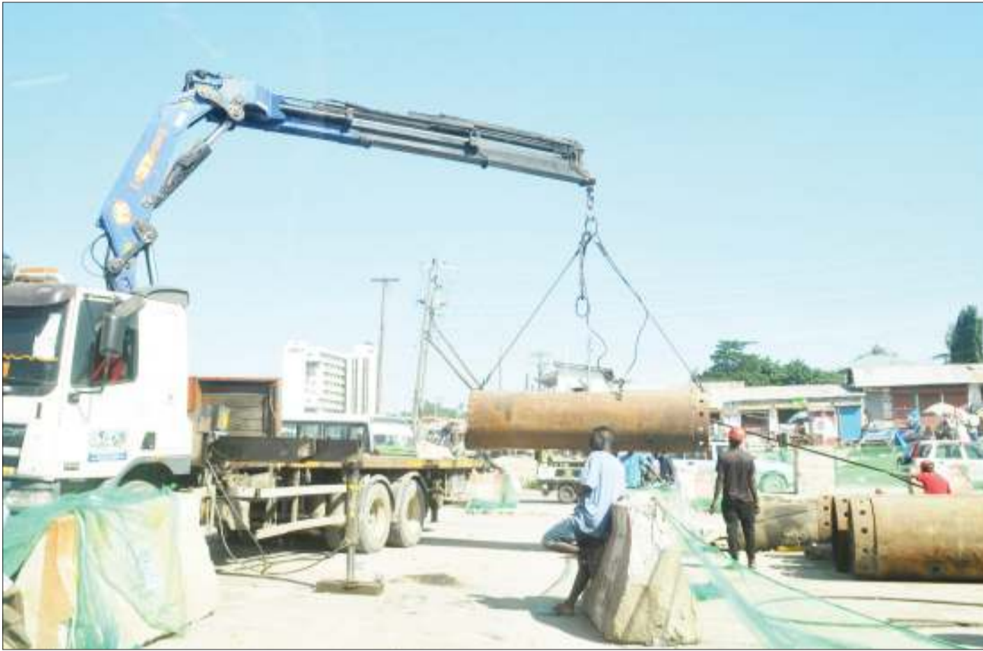
Mafundi wakiendelea na ujenzi wa barabara za juu (Ubungo Interchange), katika eneo la Ubungo, jijini Dar es Salaam jana. PICHA: JOHN BADI
