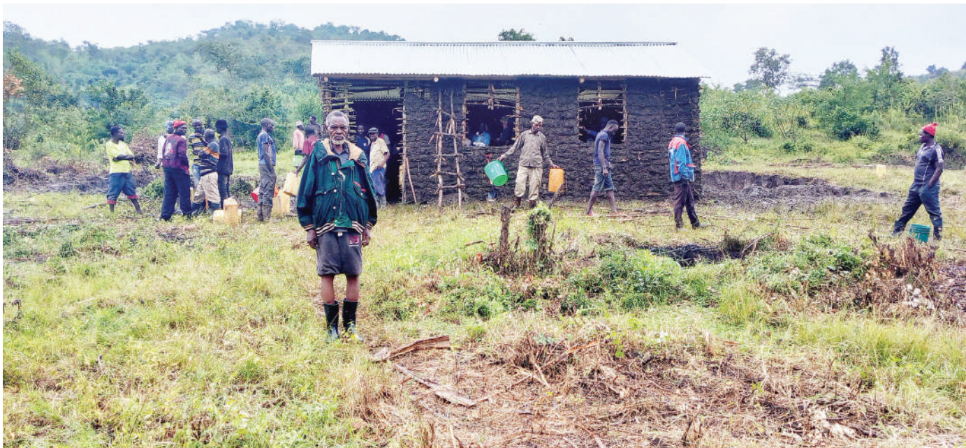
Baadhi ya wakulima na wafugaji wakishiriki kwenye ujenzi wa chumba kimoja cha darasa la wanafunzi wa shule ya awali kwenye Kijiji cha Kashanda, kata ya Nyakahanga, wilayani Karagwe, mkoani Kagera hivi karibuni. PICHA: DANIEL LIMBE
