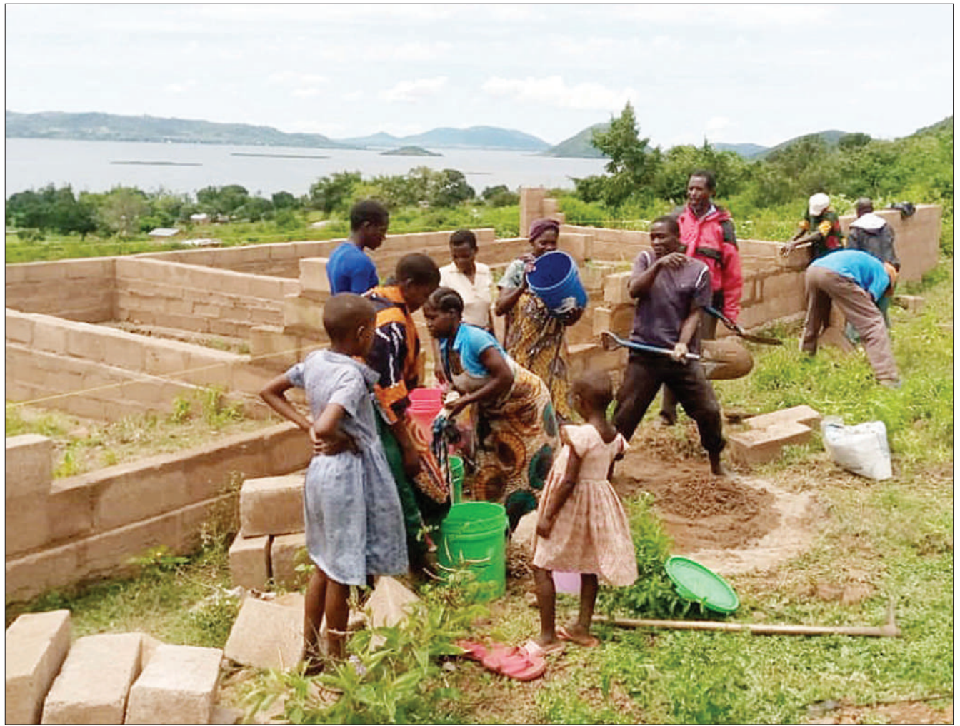
Wakazi wa kijiji cha Buraga, Kata ya Bukumi, Musoma Vijijini mkoani Mara, wakishiriki ujenzi wa darasa kwa ajili ya shule ya awali (shikizi), katika Kitongoji cha Mwaloni juji. PICHA: MPIGA PICHA WETU
