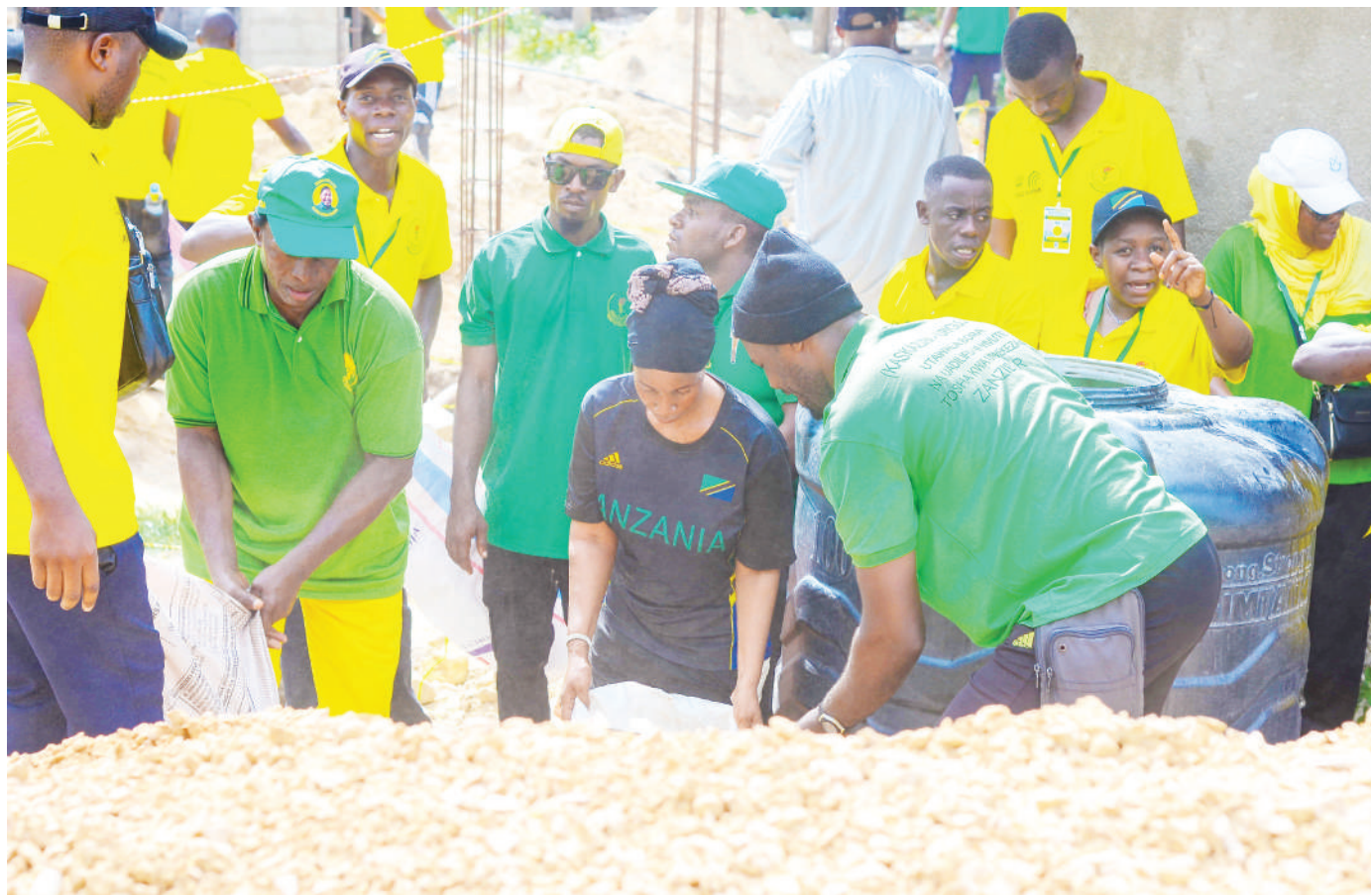
Baadhi ya Vijana wa Chama Cha Mapinduzi wakishiriki ujenzi wa nyumba ya kitega uchumi cha UVCCM Mkoa wa Kaskazini Pemba. PICHA: IS-HAKA OMAR
