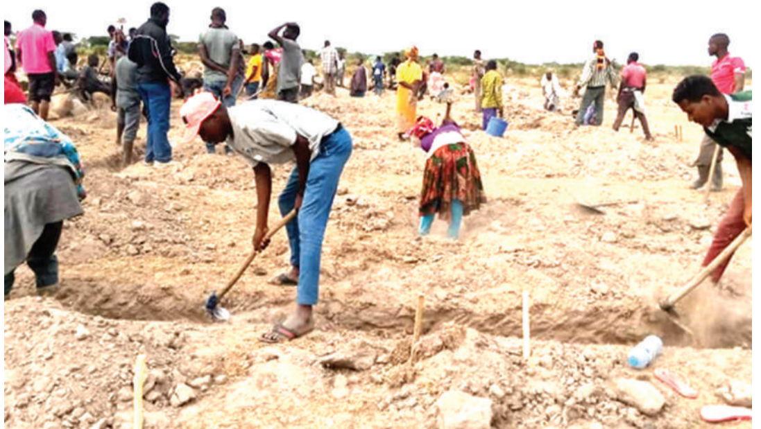
Kazi ya ujenzi wa shule ya sekondari ya kata ikiendelea, kwa kutumia mchango wa nguvu za wananchi, mkoani Mara. PICHA ZOTE: MTANDAO
