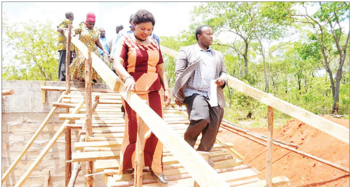
Katibu Mkuu Wizara ya Maji, Mhandisi Anthony Sanga (kulia), akiwa na Mbunge wa Jimbo la Peramiho, Jenista Mhagama, wakati wa ziara ya kukagua ujenzi wa tangi la maji kijiji cha Nakahuga, Halmashauri ya Wilaya ya Songea.
