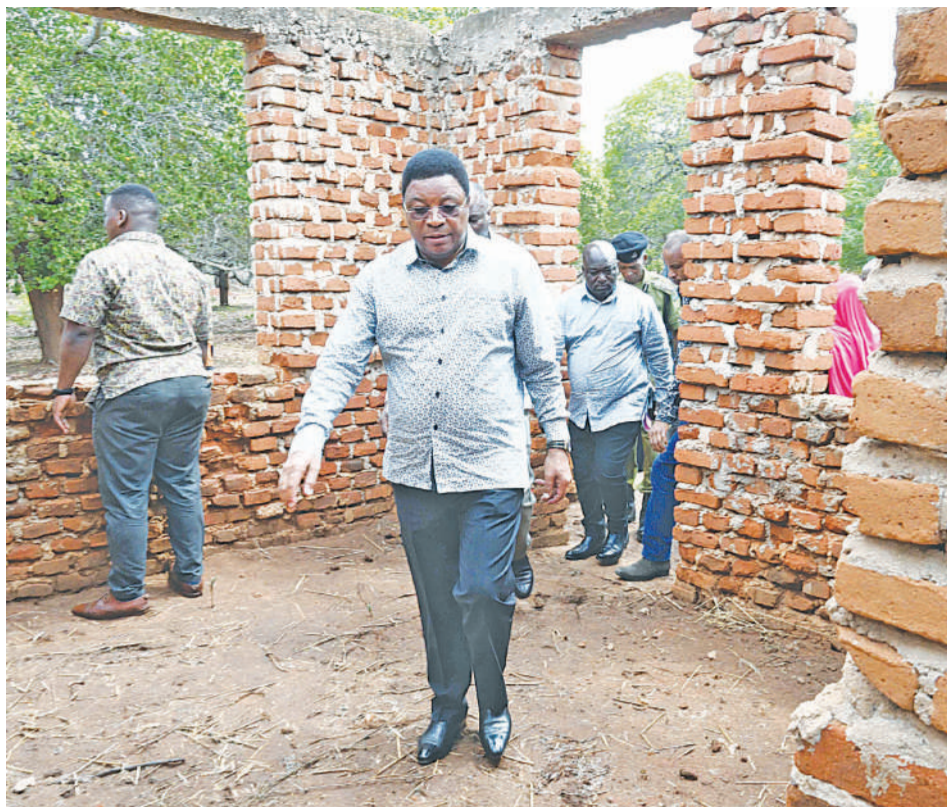
Waziri Mkuu, Kassim Majaliwa, akikagua ujenzi wa zahanati ya Kijiji cha Namilema iliyojengwa kwa nguvu za wananchi, wakati akiwa katika ziara ya kukagua miradi ya maendeleo Wilaya ya Ruangwa, mkoani Lindi jana. PICHA: OWM
