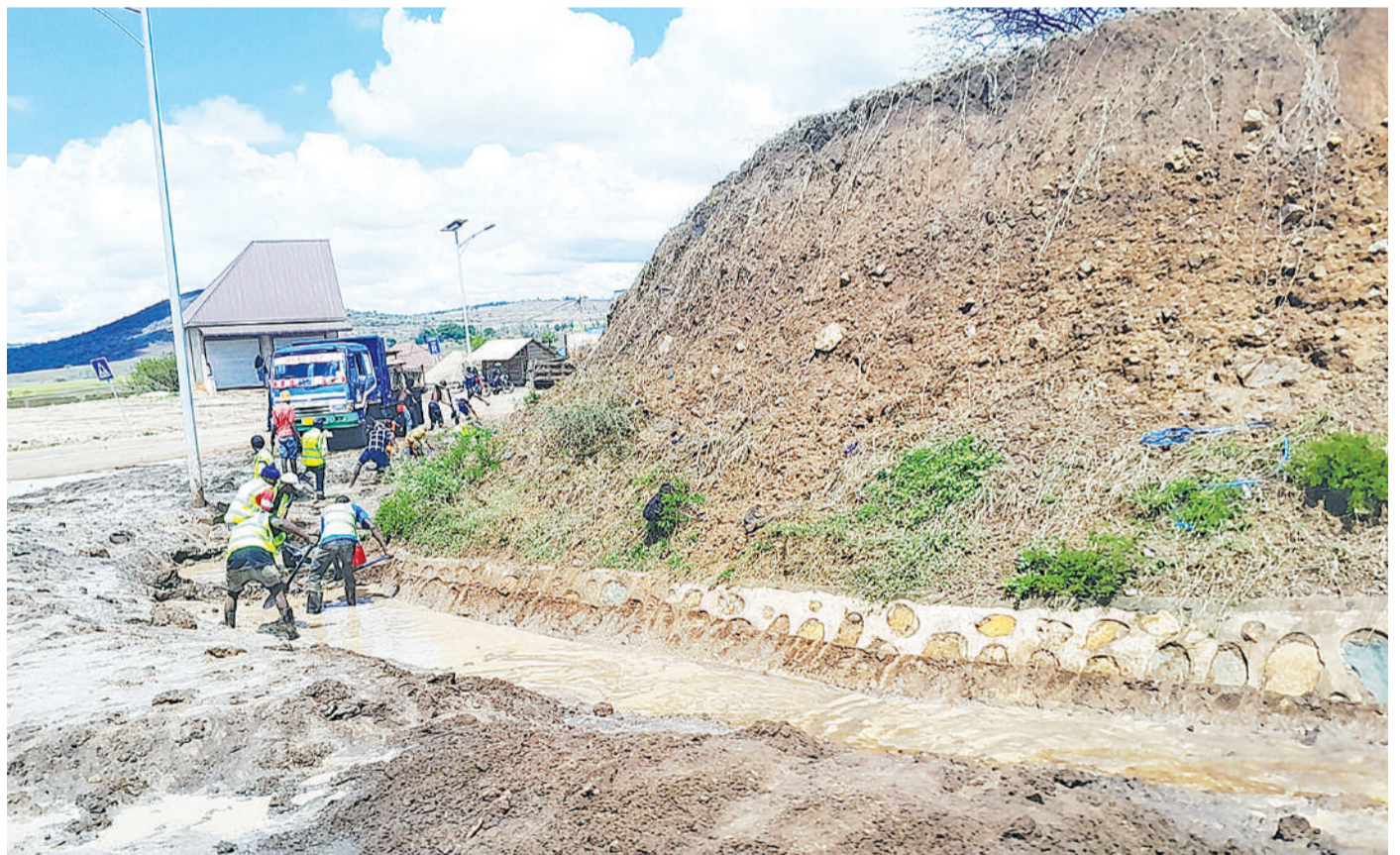
Mafundi wakitoa tope lililojaa kwenye mitaro ya maji katika Barabara ya Afrika Mashariki (Arusha Bypass) na kusababisha maji kujaa barabarani kutokana na mvua inayoendelea kunyesha jijini Arusha jana. PICHA: GETRUDE MPEZYA
