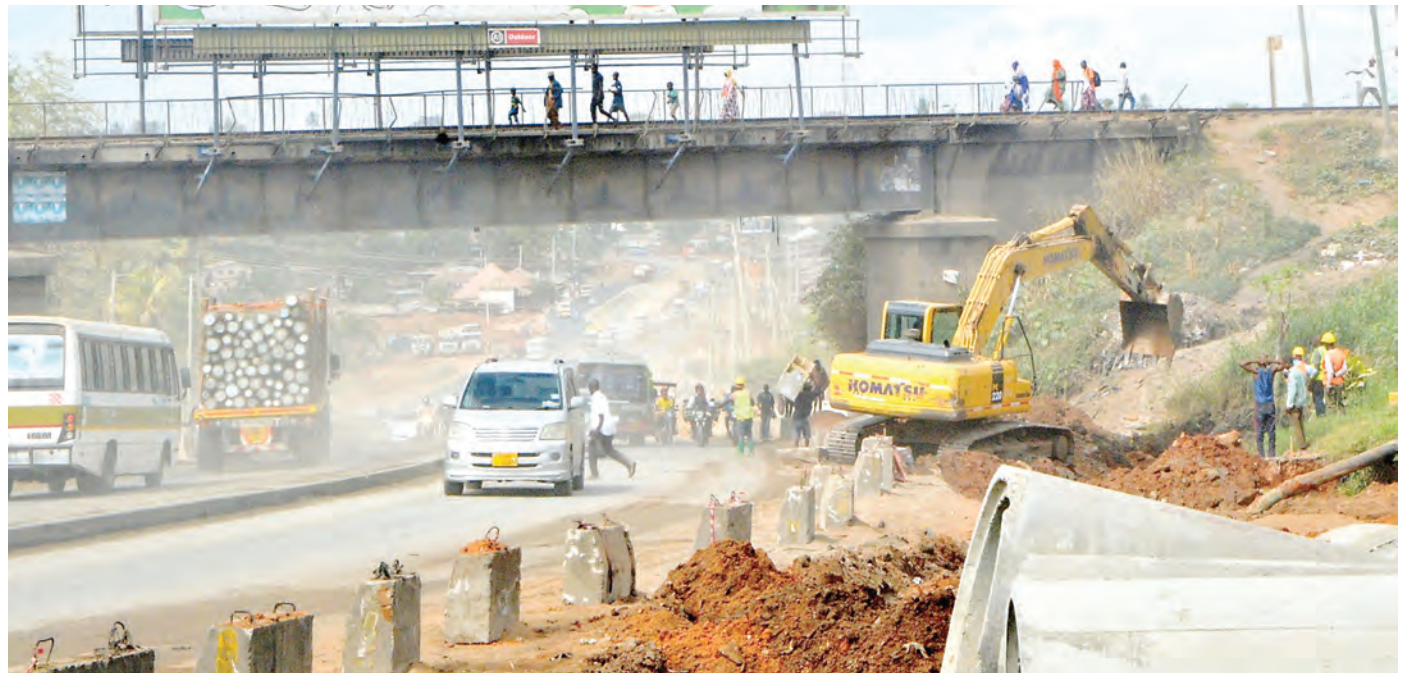
Mafundi wakiendelea wa upanuzi wa barabara ya Kilwa, eneo la Mtoni Mtongani, mkoani Dar es Salaam jana. Kutokana na ujenzi unaoendelea wa miundombinu ya barabara ya mabasi ya mwendokasi kutoka Mbagala hadi Gerezani, eneo hilo limekuwa likisababisha foleni kubwa ya magari na usumbufu kwa watumiaji wa barabara hiyo. Picha: MIRAJI MSALA
