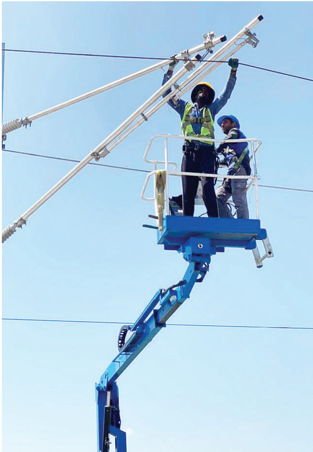
Baadhi ya mafundi wa kampuni ya ujenzi wa mradi wa reli ya kisasa (SGR) Yepi Merkezi kutoka Uturuki wakiendelea na ujenzi wa mifumo ya umeme katika kipande cha Isaka-Tabora chenye urefu wa kilometa 165 jana. PICHA: SHABAN NJIA
